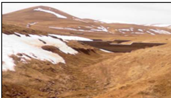
شکل ۱۲: نمایی از بند رسوب‌گیر احداث شده حوضه آبخیز گزازچای سال ۸۵
