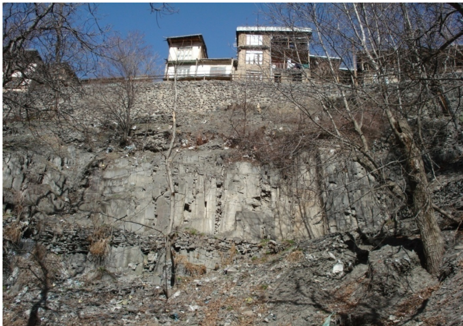
شکل ۶. تحریک دامنه‌ها از طریق توسعه ساخت‌وسازها در دامنه‌های شمالی بینالود
