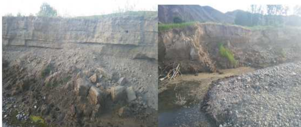
شکل ۱۰: زیر بری رودخانه و ریزش دامنه در طبقات حساس به فرسایش، شکل ۱۱- کناره رسی-سیلتی به شدت فرسایش پذیر و تخریب گسترده باغات
